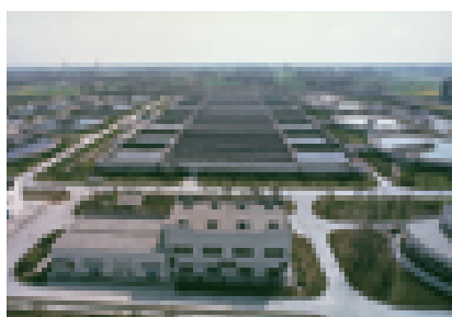
Очистка сточных вод
